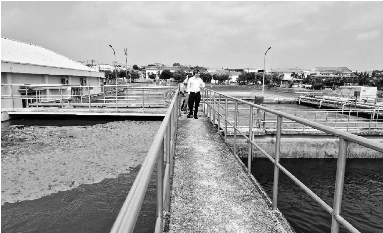
Khảo sát trạm xử lý nước thải tập trung, phục vụ mục đích tái sử dụng nước
